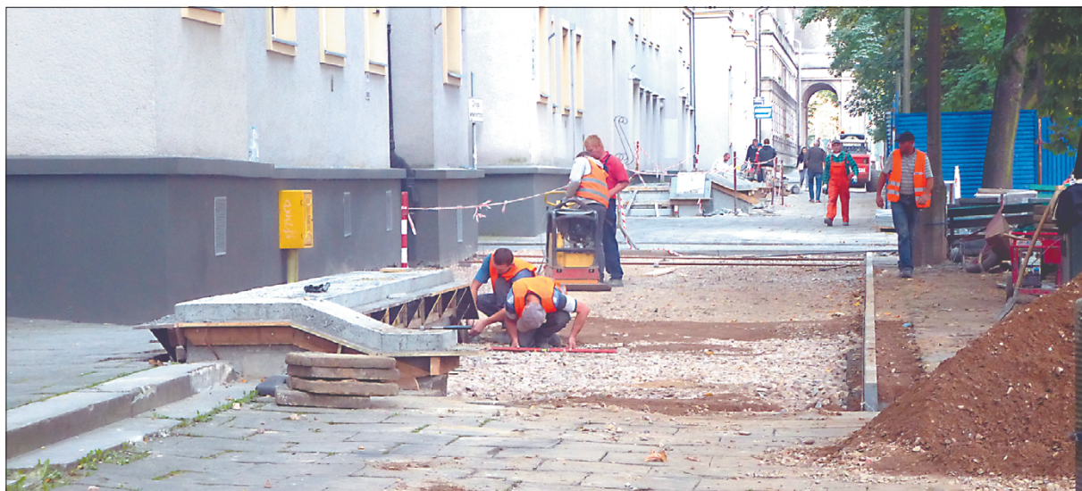
Remont murka – os. Centrum A.
